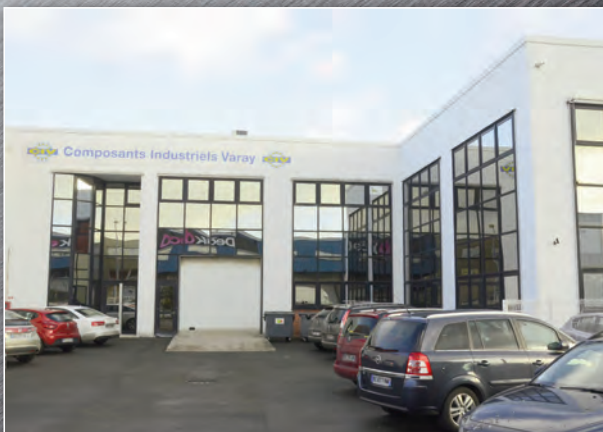
Bâtiment principal / Head office
